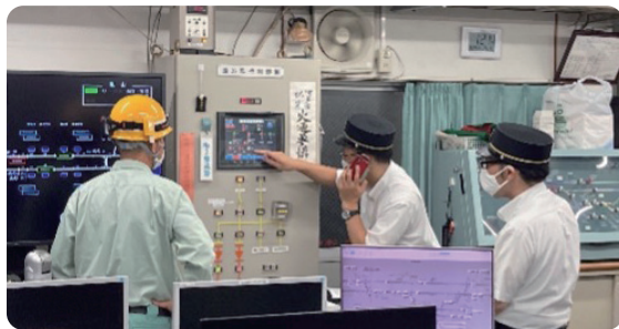
変電所故障を想定した停電復旧訓練(8月23日(月))
