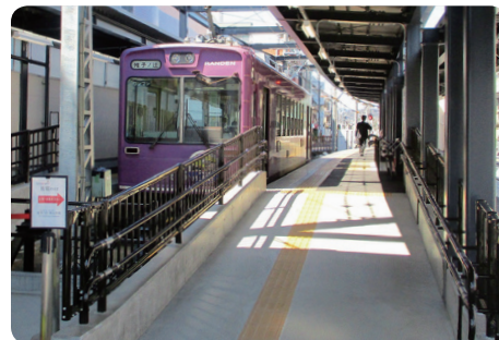
整備されたスロープと点字タイル、点字シート付手すり
