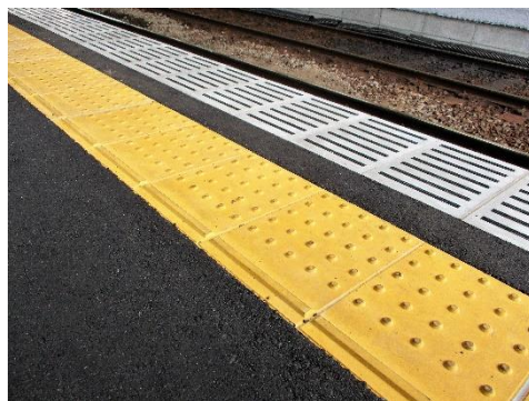
内方線付き点状ブロック設置
